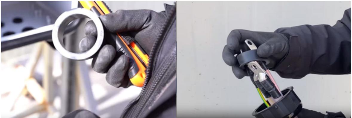
② **El diámetro del cable de CA debe cumplir con los requisitos, y el procesamiento de la funda es demasiado largo, la poda del anillo de sellado es demasiado grande, etc., dificultará el ajuste de la cubierta de sellado al cable, lo que resultará en un sellado deficiente.**
