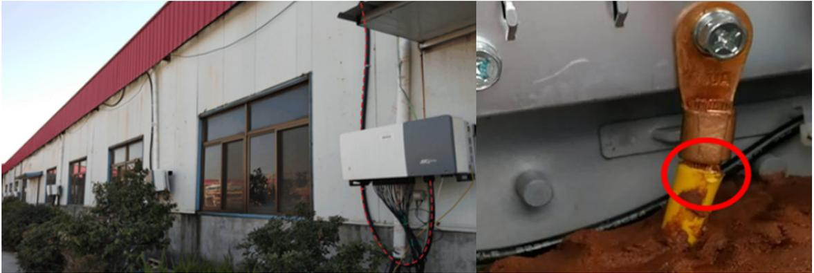
**Solución:** Cree un espacio en la parte inferior de la carcasa para permitir que fluya el agua de lluvia. Alternativamente, coloque el puerto de la funda fuera del compartimento para cables, evitando que entre agua al inversor. Además, el terminal del cable de tierra conectado al lado de CA del inversor debe tratarse con una funda termorretráctil para evitar que el agua de lluvia entre al inversor a través de la funda del cable de tierra.
