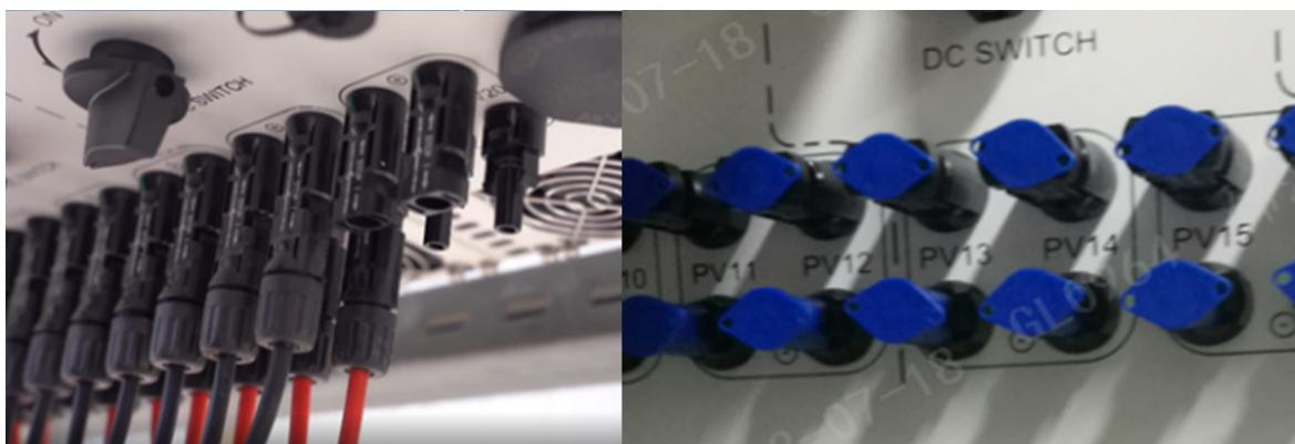
**Solução:** Garanta uma conexão CC confiável com porcas de fio apertadas. Além disso, as portas que não estão conectadas à string FV devem ser vedadas com uma tampa correspondente para evitar que chuva ou vapor de água entre no dispositivo através da porta CC:
