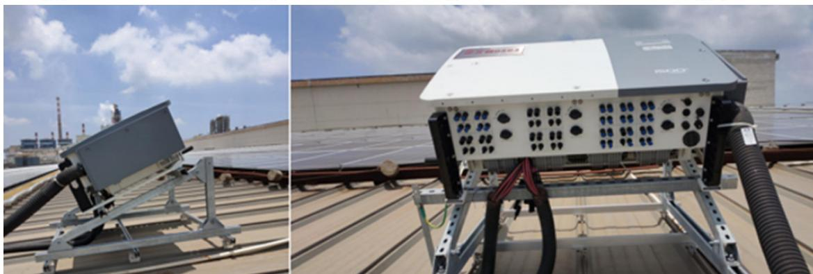
**Exemplo:** A água da chuva entra no equipamento através da interface CC
